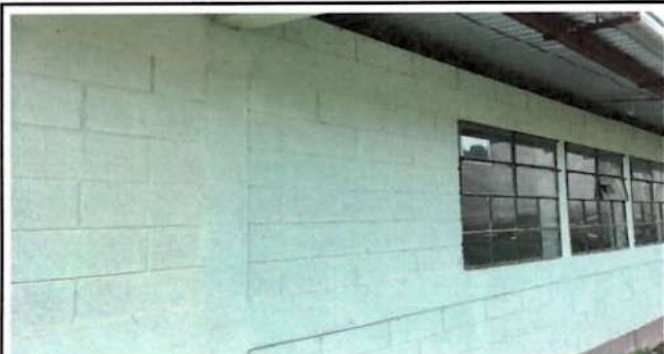
Foto1: Pintura en muros interior y exterior. Preparación de la superficie , aplicación de pintura dos manos en muro interior y exterior del establecimiento
