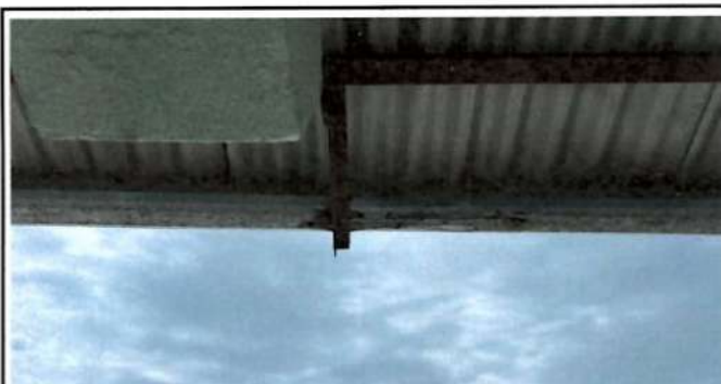
Foto 3: Canales y Bajadas de agua Pluvial. Sustitución de canales de metal para bajadas de agua pluvial Material: lámina galvanizada, tipo: lisa anclaje: sostenido con pescantes metálicos
