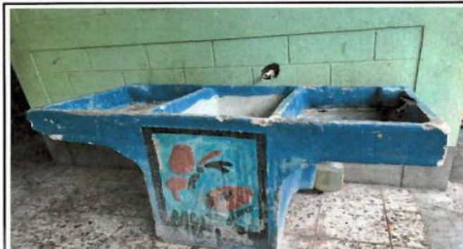
Foto 4: Reparación y sustitución de área de cocina. Sustitución de pila nivelada y conexiones hidráulicas
