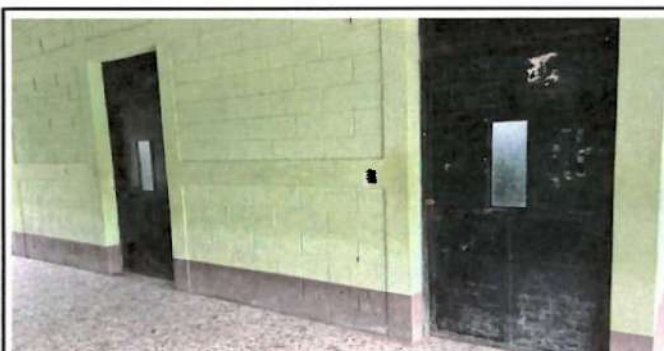
Foto 5: PUERTAS. Mantenimiento a puerta existente retiro de óxido lijado y aplicación de pintura
