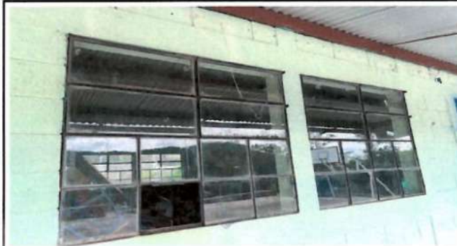
Foto 2: Ventanas. Sustitución de ventanas de PVC corredizas estándar
